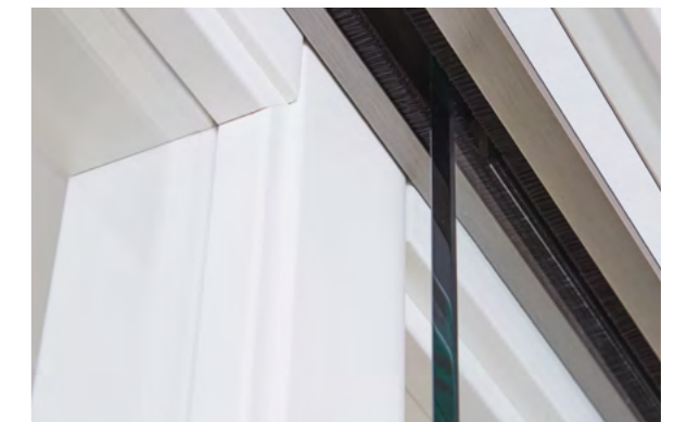
Befestigung einer Ganzglastür im Schiebetürbeschlag LINE
