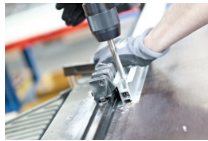
Bohrung der Profile
